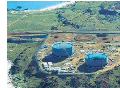
● Pluto construction site (Pluto LNG Project)
