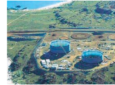
● Pluto construction site (Pluto LNG Project)
